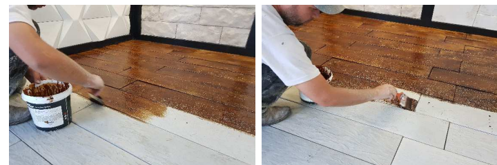
FIGURA 31. APLICAÇÃO DA RESINA
