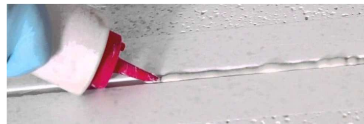
FIGURA 30. APLICAÇÃO DO REJUNTE COM A BISNAGA
