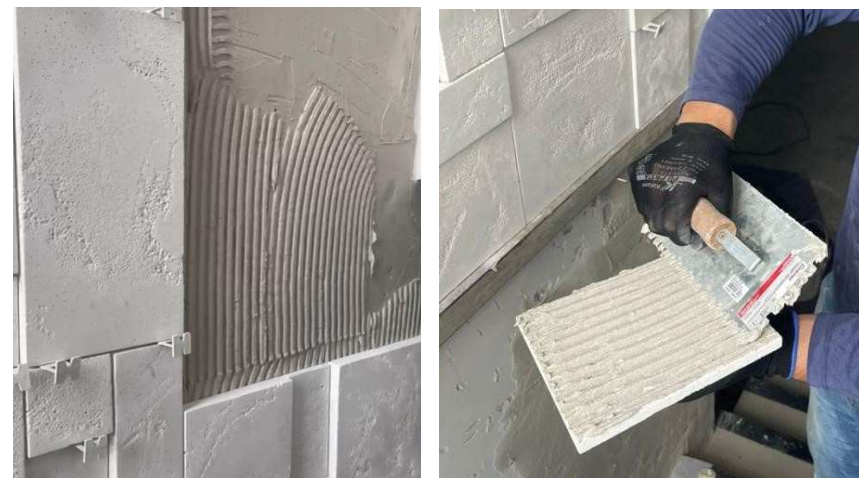
FIGURA 29. MODO DE APLICAÇÃO DA ARGAMASSA
