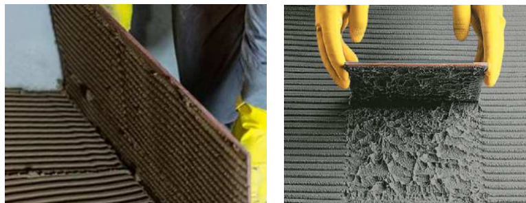
FIGURA 4. APLICAÇÃO DA ARGAMASSA EM COLAGEM DUPLA
